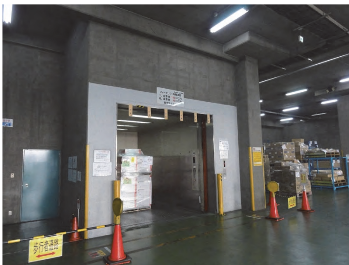
(エレベータからフォークリフトが出てきたときにそこを横切る者との接触危険への対策です。)
